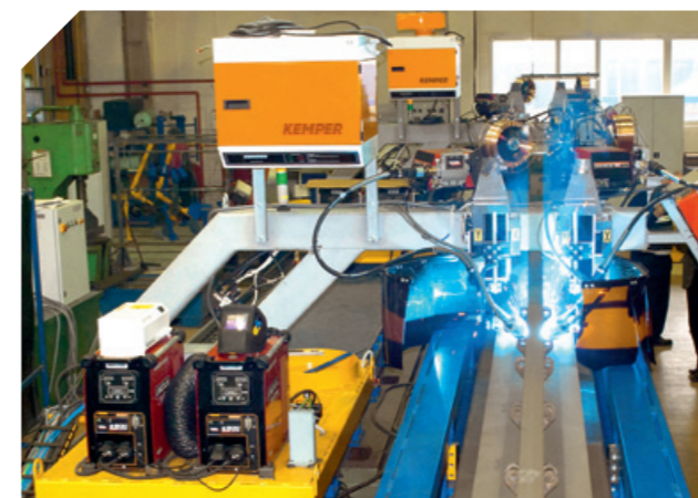
Одновременная сварка двумя горелками
