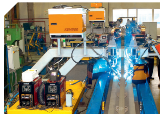
Одновременная сварка двумя горелками
