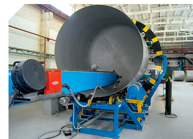
Сварка внутреннего шва
